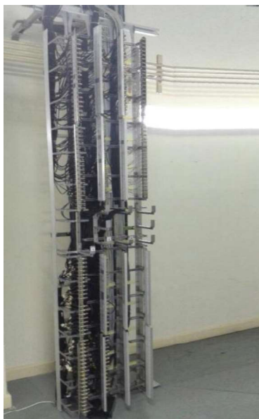
تصویر محفظه (تابلو-رک) مربوط به DDF الکتریکی
