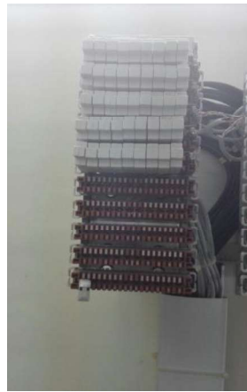
کانکتورهای mdf با پوسته و فیوز سمت مشترک
